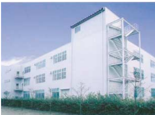
高崎営業所増築倉庫全景
