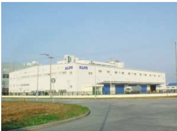
アルプス物流(上海)有限公司全景
