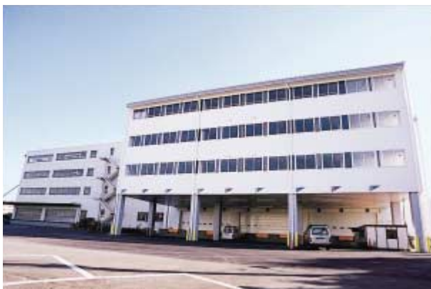
横浜営業所新倉庫棟全景
