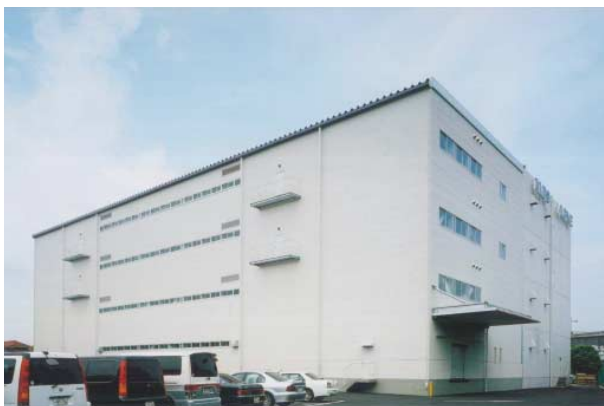
大阪営業所増築倉庫棟全景
