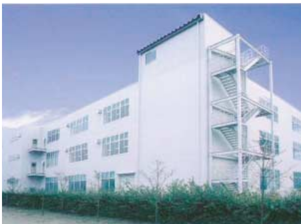
高崎営業所増築倉庫全景
