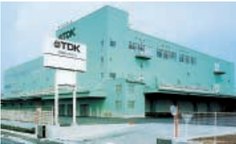
TDK 物流(株) 本社・関東流通センター
