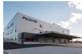
昨年増築した群馬営業所2号棟倉庫
